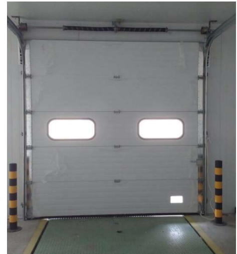
Panel seccional de aluminio con ventana de cristal
