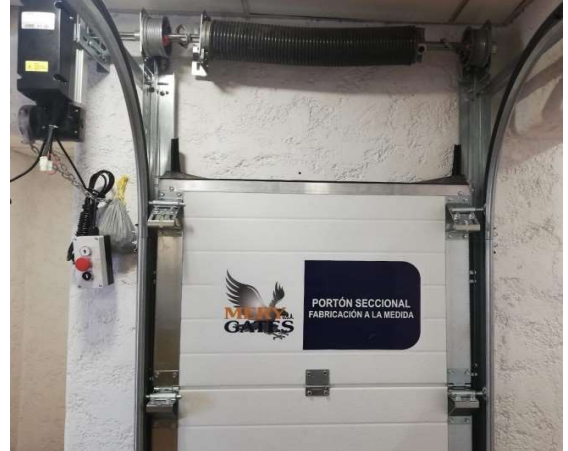
Panel metálico doble cara con relleno de poliuretano
